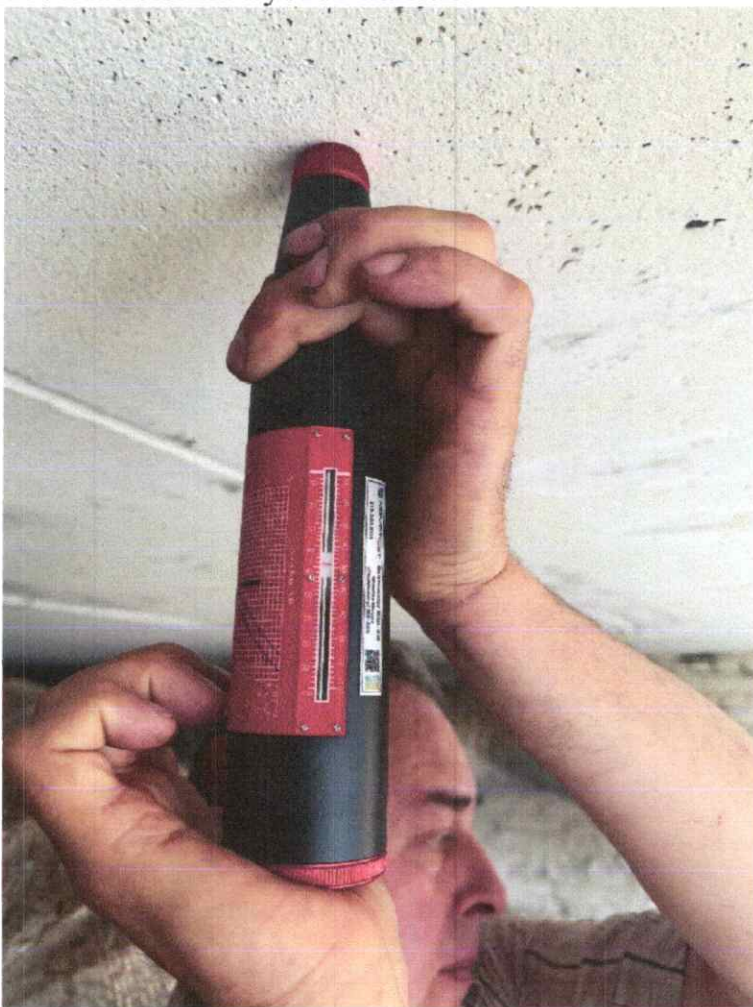
Фото №14. Визначення міцності бетону.
